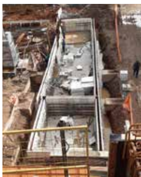
Piscinas, Caixas e Reservatórios
