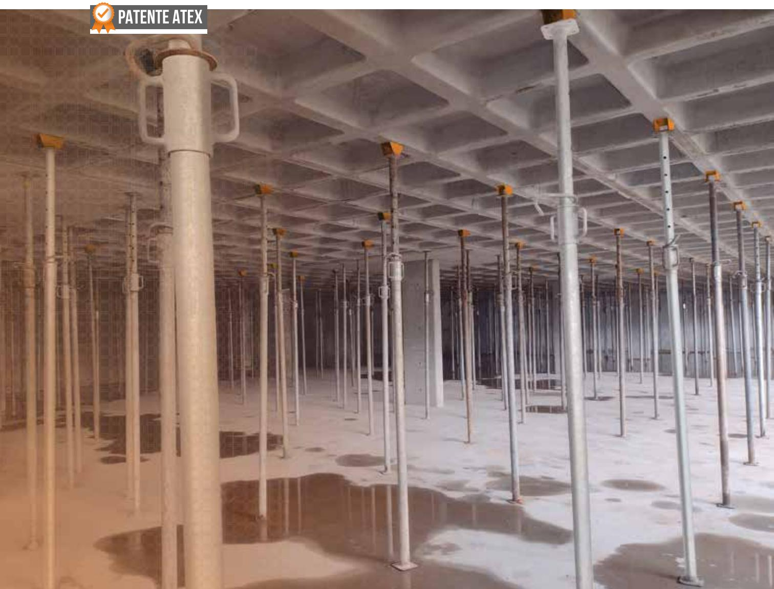
O Sistema Cabetex simplifica a montagem e desmoldagem das fôrmas. **Além de reduzir a geração de resíduos, o sistema pode acelerar o processo de concretagem.**
